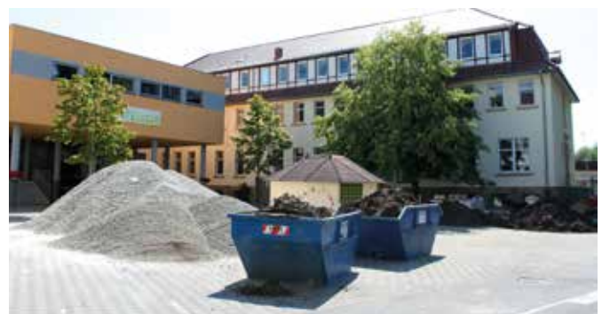
Der Schulhof als Baustelle
