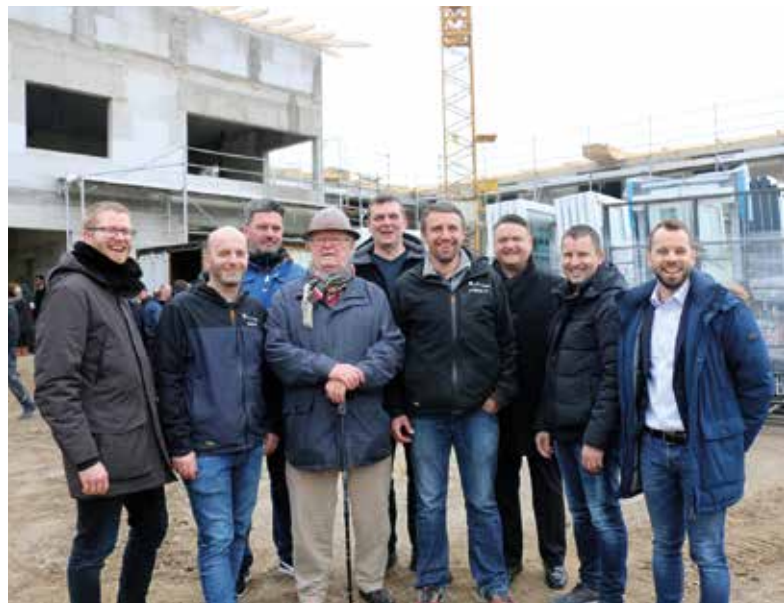
Am 5. März konnte in Bechterdissen das Richtfest gefeiert werden. Mit dabei u. a. die Geschäftsführer vom CSV-Lippe (Peter Dück, 3. v. r.) und CSW OWL (Arthur Giesbrecht, rechts), Architekt Eugen Unruh (2. v. r.) und die Bauleiter Daniel Krein (2. v. l.) und Andreas Klassen (4. v. r.).
