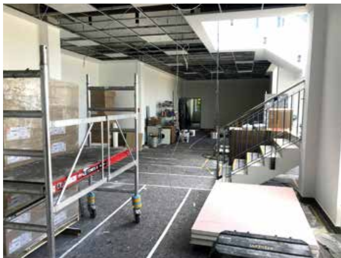
Der Eingangsbereich der ehemaligen Grundschule ist in der Bauzeit kaum wiederzuerkennen.
