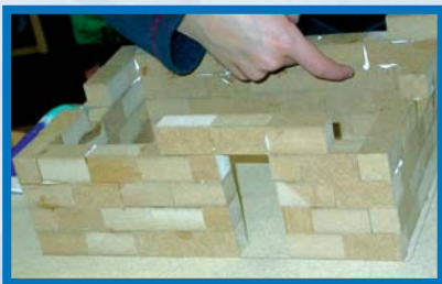
Stürze für Fenster und Türen wurden vorgeleimt. Wo kommt bloß der Leimtropfen her?
